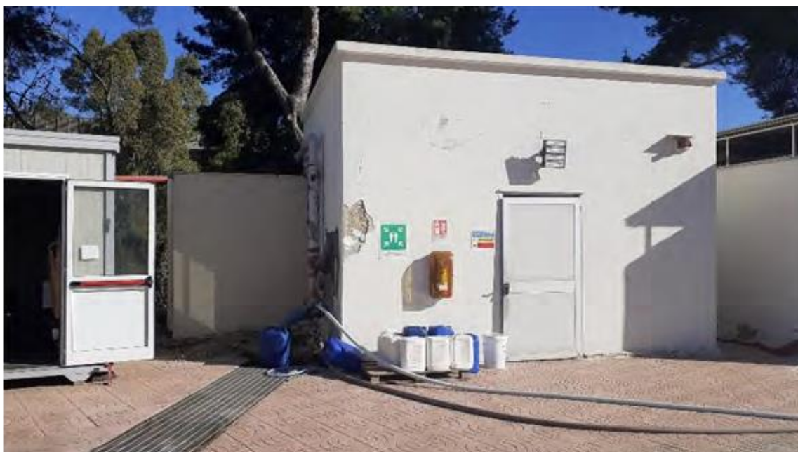
Foto 7: Locale pompe – vista sud
