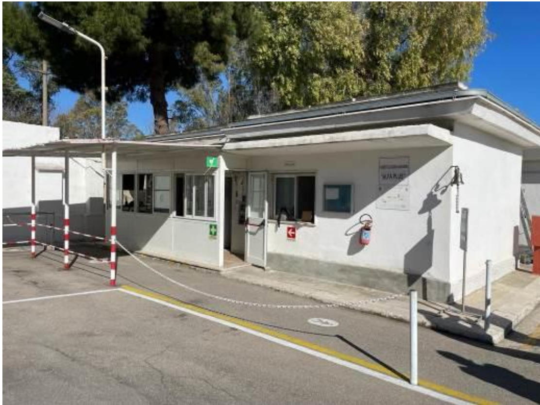
Foto 1: esterno Corpo di guardia – prospetto principale
