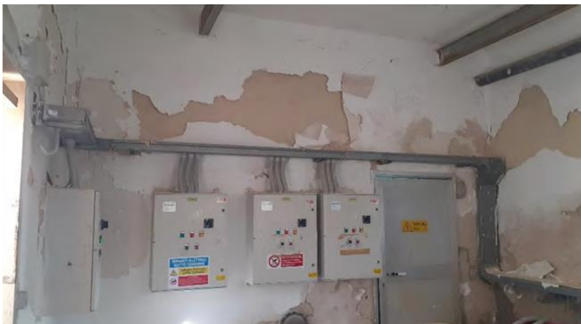
Foto 8: Locale pompe – interno
