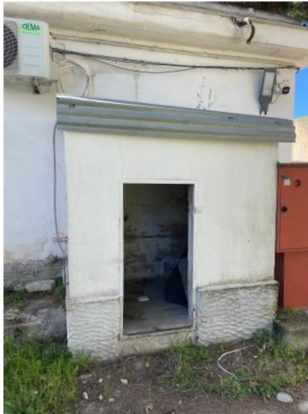
Foto 5: esterno locale calderina
