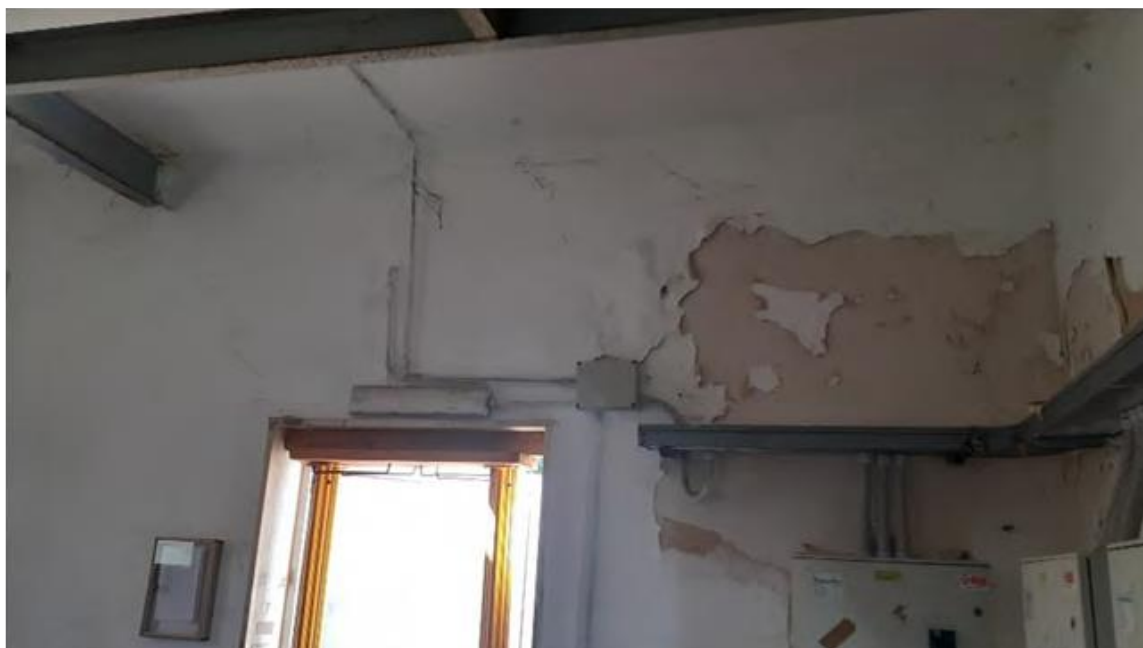
Foto 9: Locale pompe – interno
