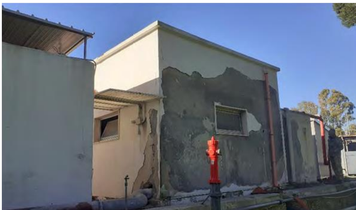
Foto 7: Locale pompe – vista nord
